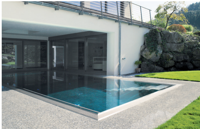
samacostyle veredelte einen sichtbar gealterten Betonpool mit einem eleganten Edelstahlbecken.
